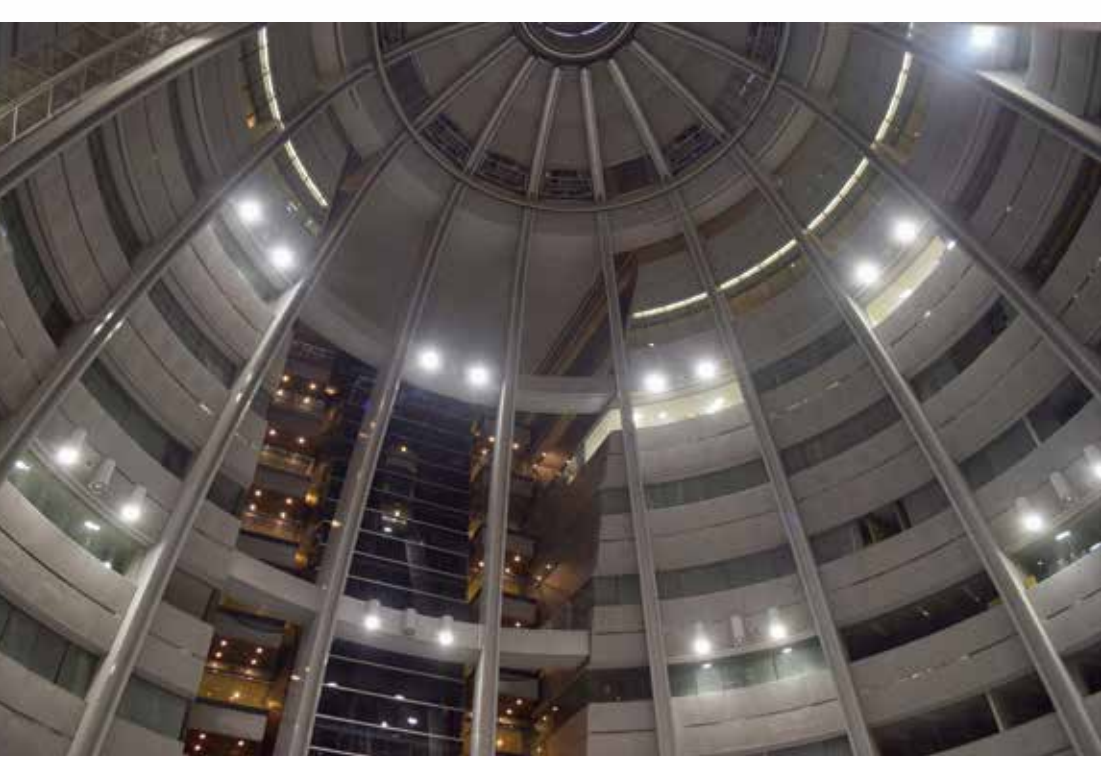
アトリウムプラザの天井
