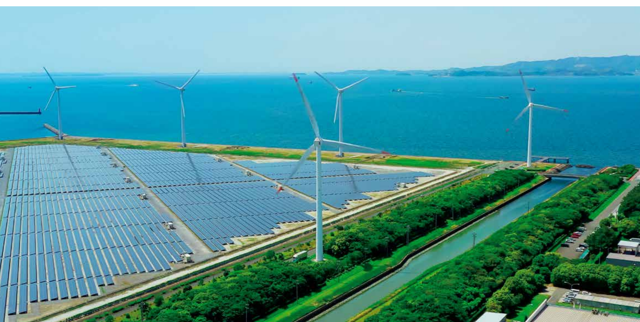
サステナブルエネルギーとして期待されるメガソーラー・風力発電
